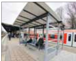
Alle geplanten Wetterschutzhäuschen sind fertig.
