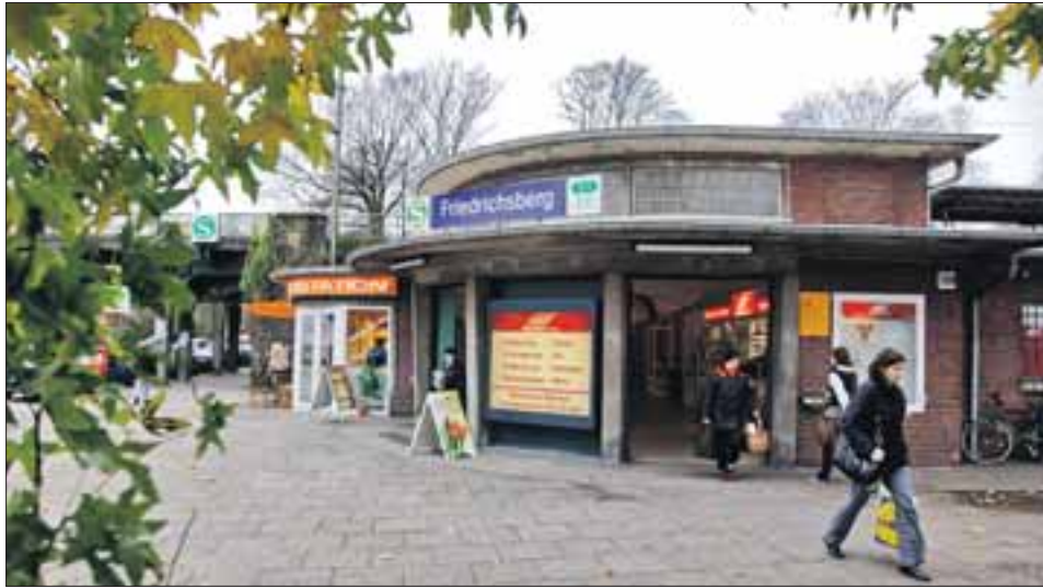
Die S-Bahn-Station wird derzeit modernisiert – ein barrierefreier Zugang entsteht 2010.
