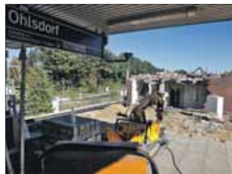
Am S-Bahnhof Ohlsdorf wird derzeit ein Aufzug gebaut
